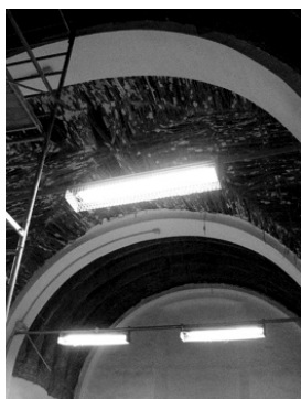
Fig. 9 - Ex oratorio della Confraternita del SS. Sacramento, poi chiesa di S. Giovanni Battista: particolari della volta di canne e centine lignee senza intonaco per restauri
