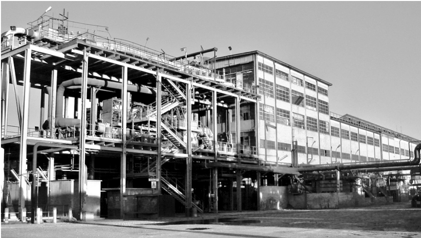
Fig. 8 - Fabbricati di "Casa bietole" ampliati nel 1969 (foto del 2005)
