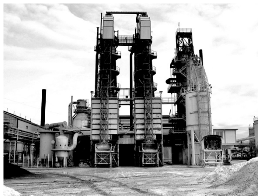
Fig. 11 - Dicembre 2005. I forni da calce in attesa dei lavori di demolizione
