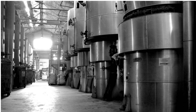
Fig. 9 - "Corpi di evaporazione" in una immagine del 2005
