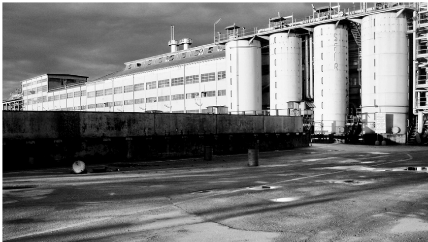
Fig.14 - Dicembre 2005. La fabbrica in attesa dei lavori di demolizione
