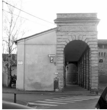
Fig. 15 – Fianco del complesso
