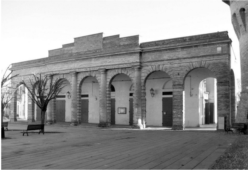
Fig. 13 – Prospetto anteriore dell'edificio
