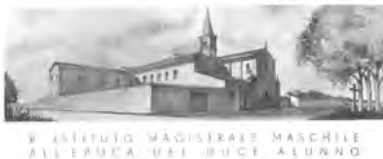
Fig. 2 - Il complesso visto da chi proveniva da Cesena, in una stampa per cartolina come doveva apparire alla fine dell'Ottocento
