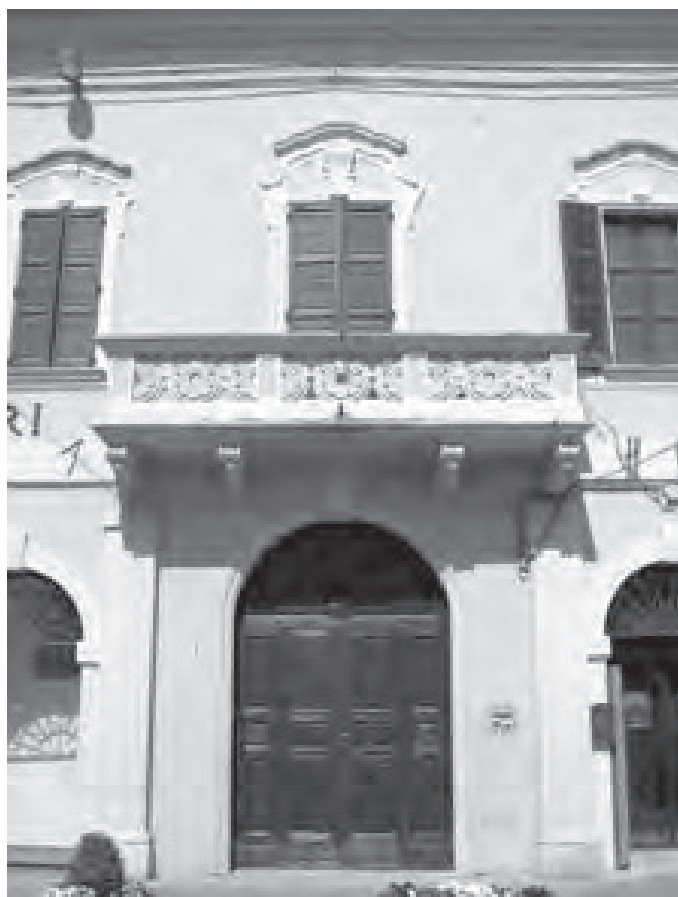
Fig. 8 - Palazzo Colombani-Ginanni (ora Fabbri): balcone
