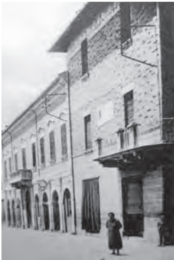
Fig. 11 - Palazzo in angolo tra piazza Garibaldi e via A. Costa: configurazione originaria
