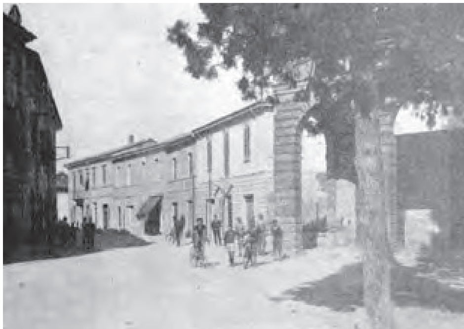
Fig. 13 - Via V. Veneto: case in costruzione sul lato interno
