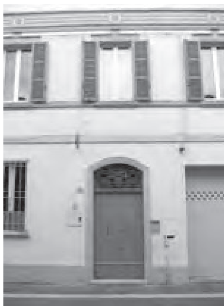
Fig. 5 - Case gemelle affrontate in via Saffi: cornici sulle finestre, negli ingressi e marcapiani
