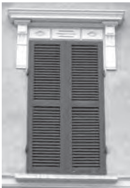
Fig. 17 - Penultima casa in via V. Veneto: finestra ornata con litocemento
