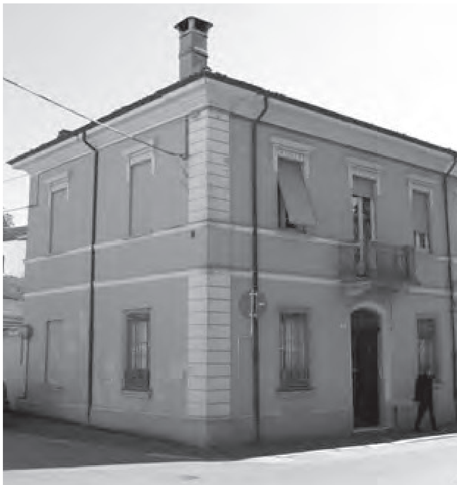
Fig. 18 - Casa in angolo tra via V. Veneto e via Monte Grappa: prospetti anteriore e laterale
