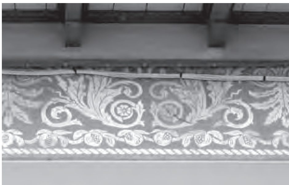
Fig. 10 - Palazzo in angolo tra piazza Garibaldi e via A. Costa: tratto di decorazione pittorica nel sottogronda
