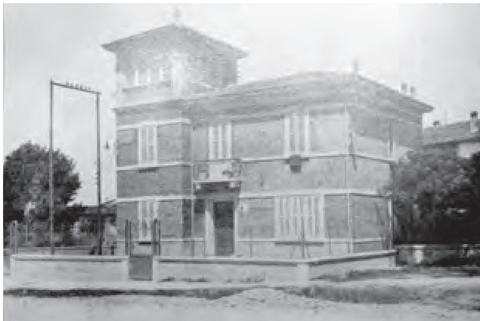
Fig. 39 - Cabina di trasformazione tensione - villino S.E.R.: configurazione originaria
