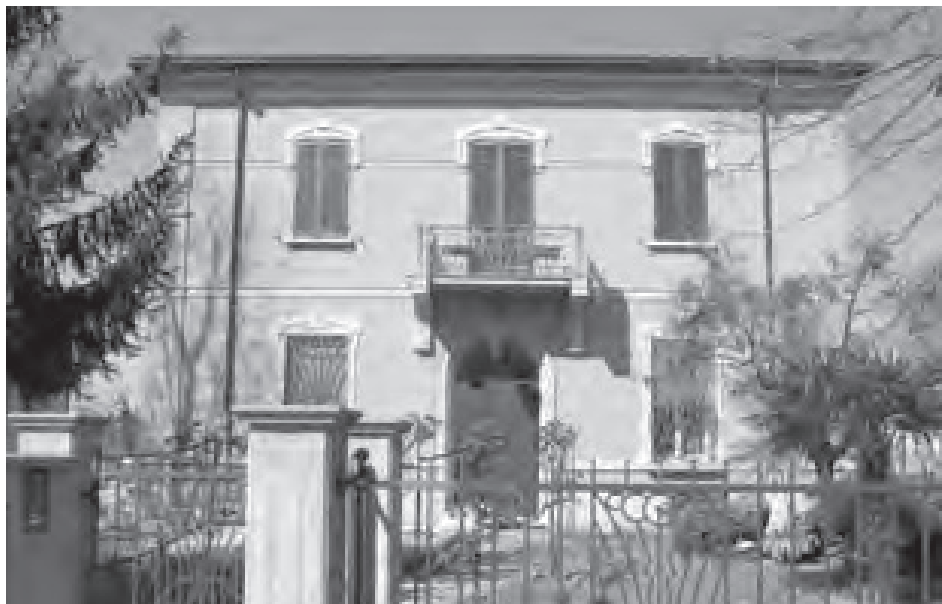
Fig. 25 - Villino in frazione S. Andrea: prospetto anteriore
