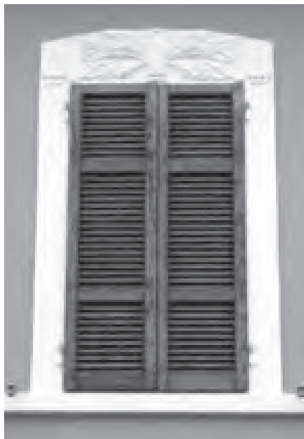
Fig. 16 - Casa in via V. Veneto: finestra ornata con litocemento
