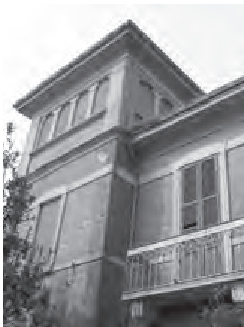
Fig. 42 - Cabina di trasformazione tensione - villino S.E.R.: balcone
