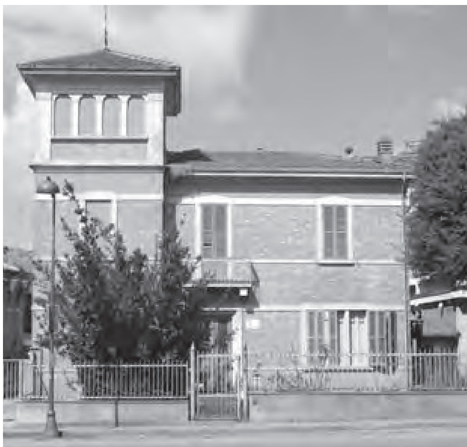
Fig. 40 - Cabina di trasformazione tensione - villino S.E.R.: prospetto anteriore
