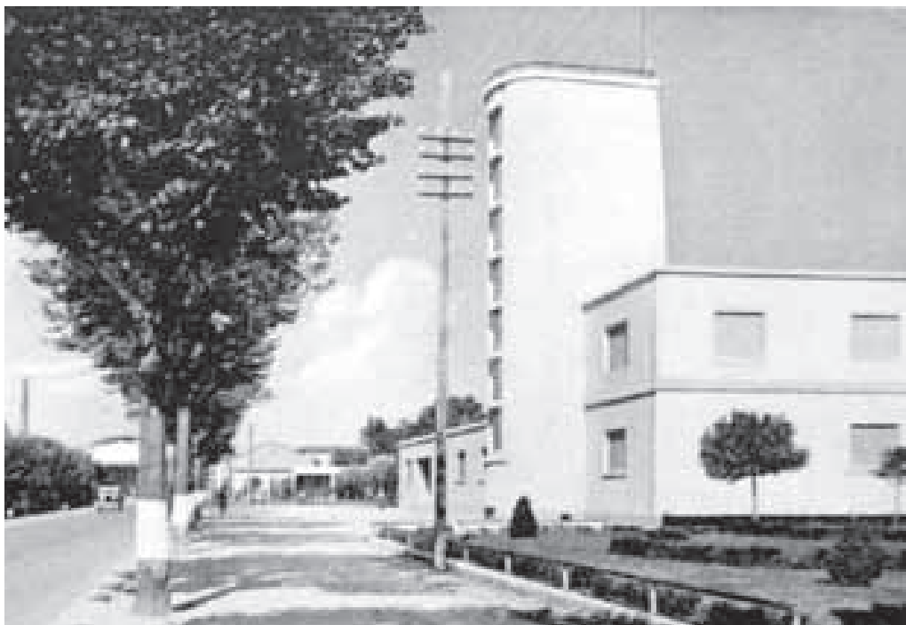
Fig. 8 - Forlimpopoli, fianco est e scorcio del prospetto anteriore (sud) della Casa O.N.B. - G.I.L.; stato originario
