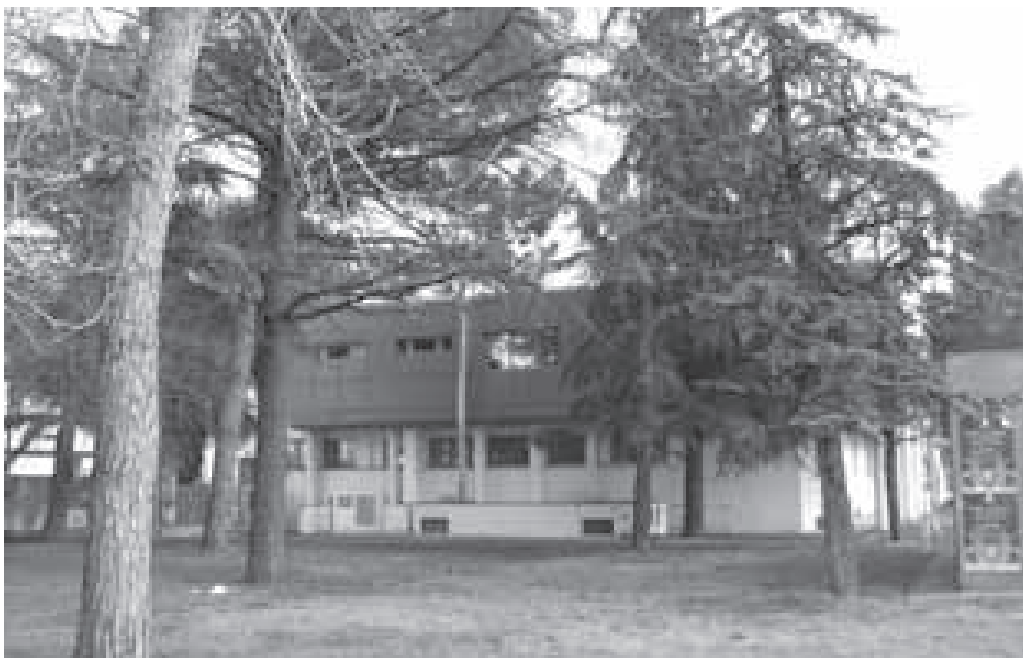
Fig. 2 - Forlimpopoli, ex Casa O.N.B. - G.I.L., fianco ovest; stato attuale
