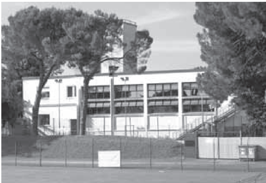
Fig. 9 - Forlimpopoli, prospetto posteriore (nord) della ex Casa O.N.B. - G.I.L. con la riduzione della vetrata della palestra ed altri elementi aggiunti nel dopoguerra; stato attuale.
