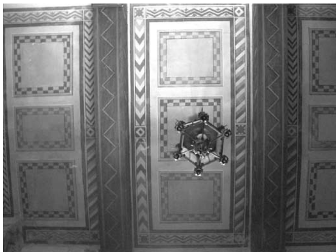
Fig. 40 - Parte centrale del soffitto presente nel vano scala.
