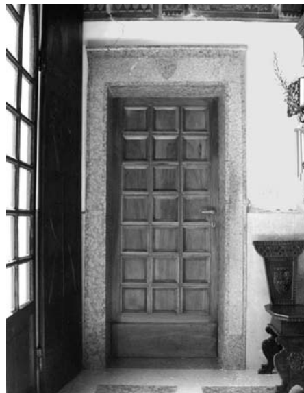
Fig. 39 - Cornice marmorea di una porta interna.
