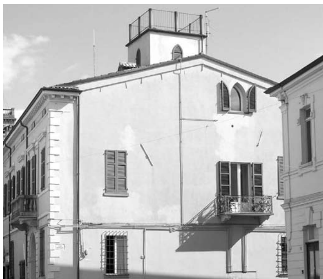
Fig. 2 - Palazzo già in proprietà alla famiglia Uccellini con la torretta sulla quale si aprono finestrelle ogivali simili a quella presente nel muro perimetrale di via Vecchiazzani.
