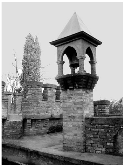
Fig. 22 - Camino - pinnacolo con campana.
