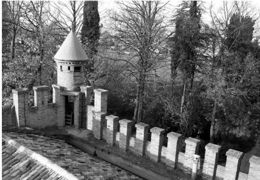
Fig. 24 - Tetto della villa con entrata alla garitta e camminamento di ronda.
