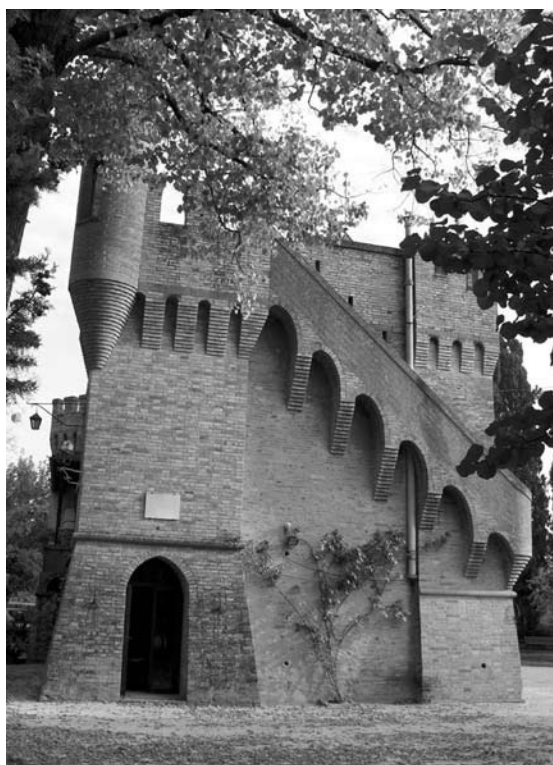
Fig. 20 - Fianco ovest della villa.
