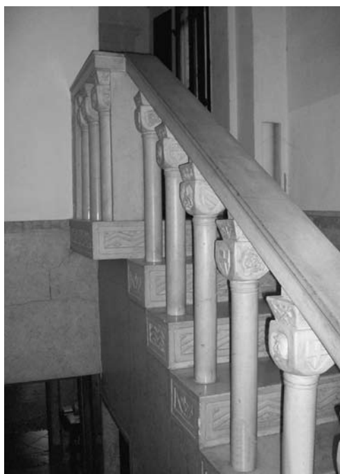
Fig. 41 - Scala d'accesso al piano superiore.
