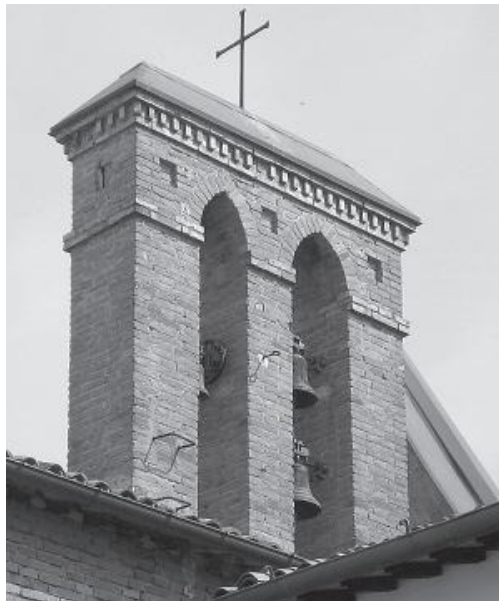
Fig. 18 - Campaniletto visibile soltanto, oltre che dall'area interna monasteriale, anche da alcune case e cortili privati limitrofi.
