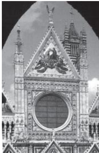
Fig. 10 - Duomo di Siena (dal 1229): particolare di foglie rampanti.
