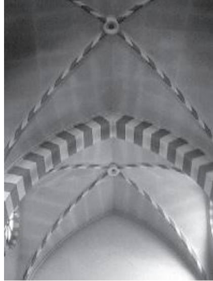
Fig. 26 - Sistema delle volte a crociera con costoloni e chiavi (serraglie).
