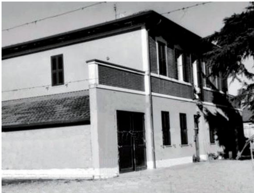
Casa colonica in via Erbosa n. 52, adibita scuola nell'a.s. 1938 – 1939.
