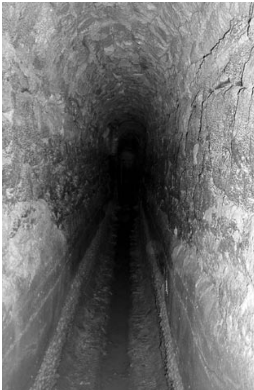
Fig. 4. Fratta Terme. Interno della conduttura antica recentemente individuata (da VERNIA 2005).
