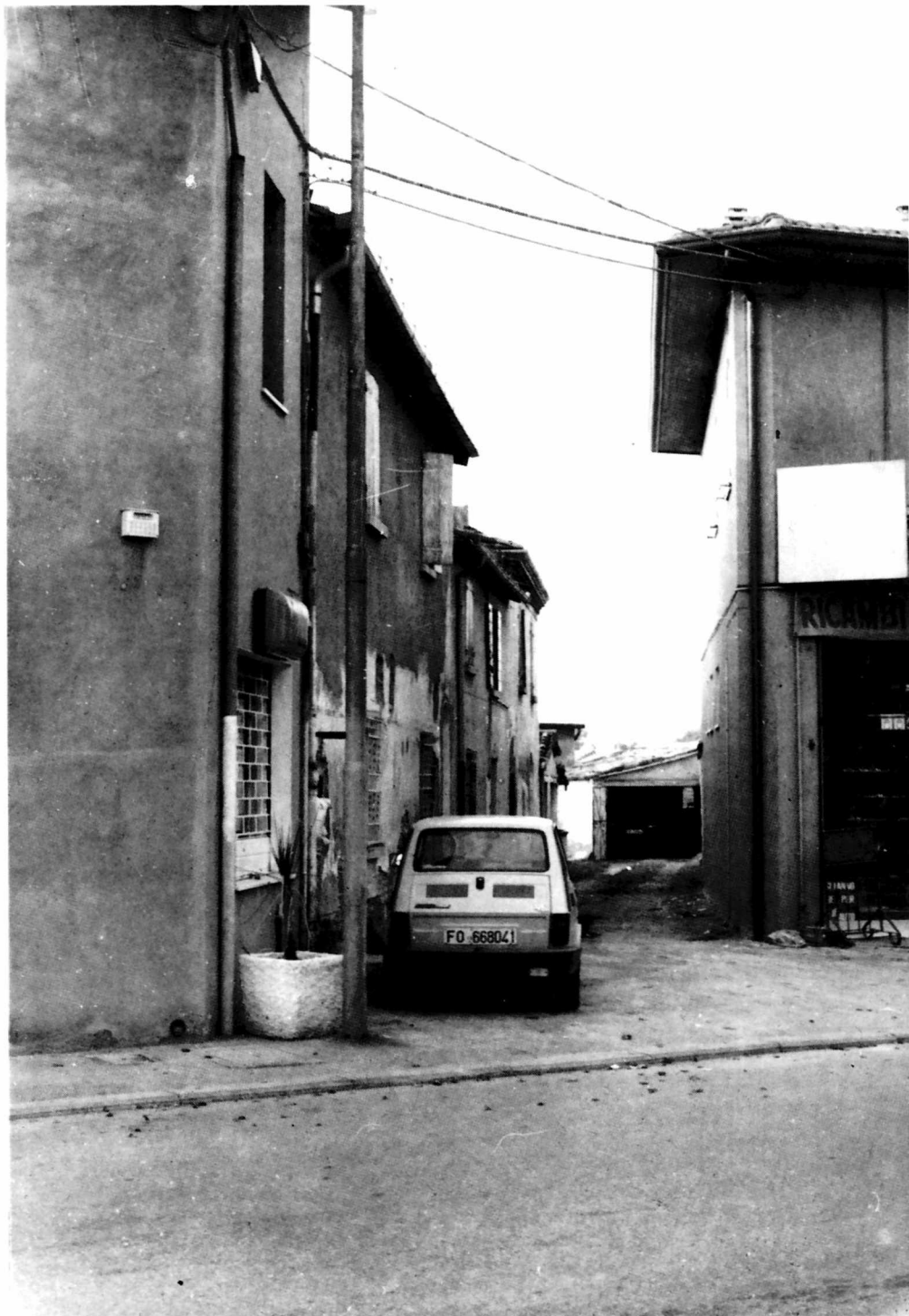
Fig. 3 - FORLIMPOPOLI, Vicoletto cieco che ha origine dalla Via Baldini . Esso ricalca un antico percorso dell'Emilia, attivo fino ai primi anni dell'Ottocento. Le case poste sul lato meridionale della stradiciola sorsero sulla vecchia sede stradale abbandonata (che era molto più larga dell'attuale), dopo che era stato costruito il Camposanto cittadino ed era stata attuata la deviazione dell'Emilia lungo il nuovo asse della Via XXV Ottobre.
