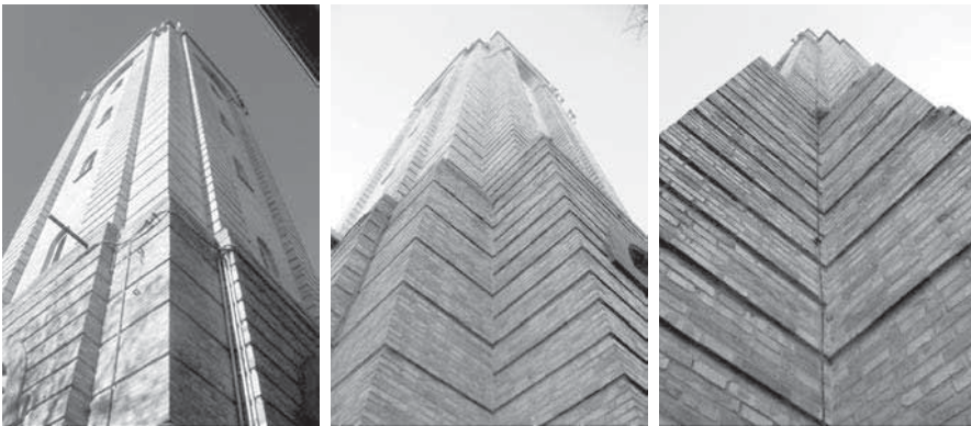
Figg. 23, 24, 25 - Geometrie composte con corsi di mattoni accostati in rapporto 1-2
