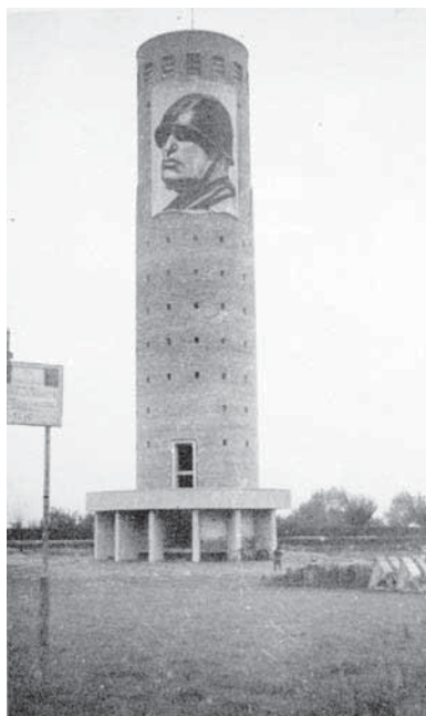
Figg. 13, 14 - G. SERUGHI, Torre serbatoio 1938 : parte anteriore con il basamento-pronao, tessitura muraria a losanghe
