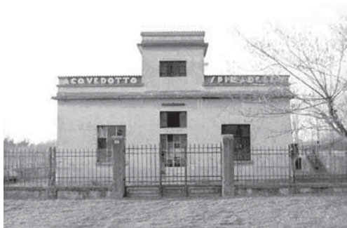
Fig. 2 - Acquedotto Spinadello, centrale di sollevamento, prospetto anteriore
