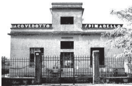
Fig. 7 - Palazzina prima dei lavori
