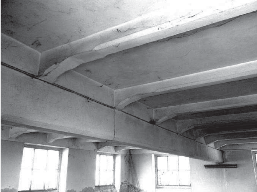
Fig. 11 - Le travi in cemento armato sagomato
