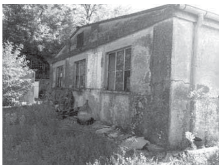
Fig. 9 - La facciata posteriore con il tetto a falde posticcio
