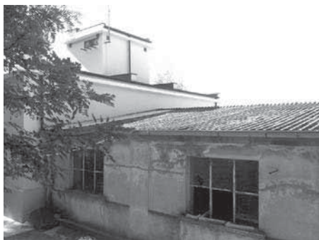
Fig. 10 - Il volume sul retro ancora da restaurare
