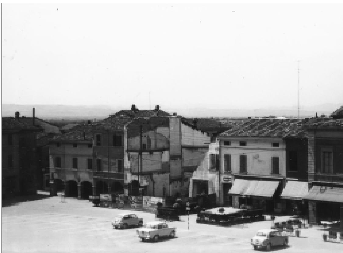
Fig. 14 - FORLIMPOPOLI. Il lato ovest della piazza Garibaldi con la Casa Artusi già abbattuta ed il vecchio edificio col Caffè Roma in attesa di imminente demolizione (foto di V. Bassetti, luglio 1961).
