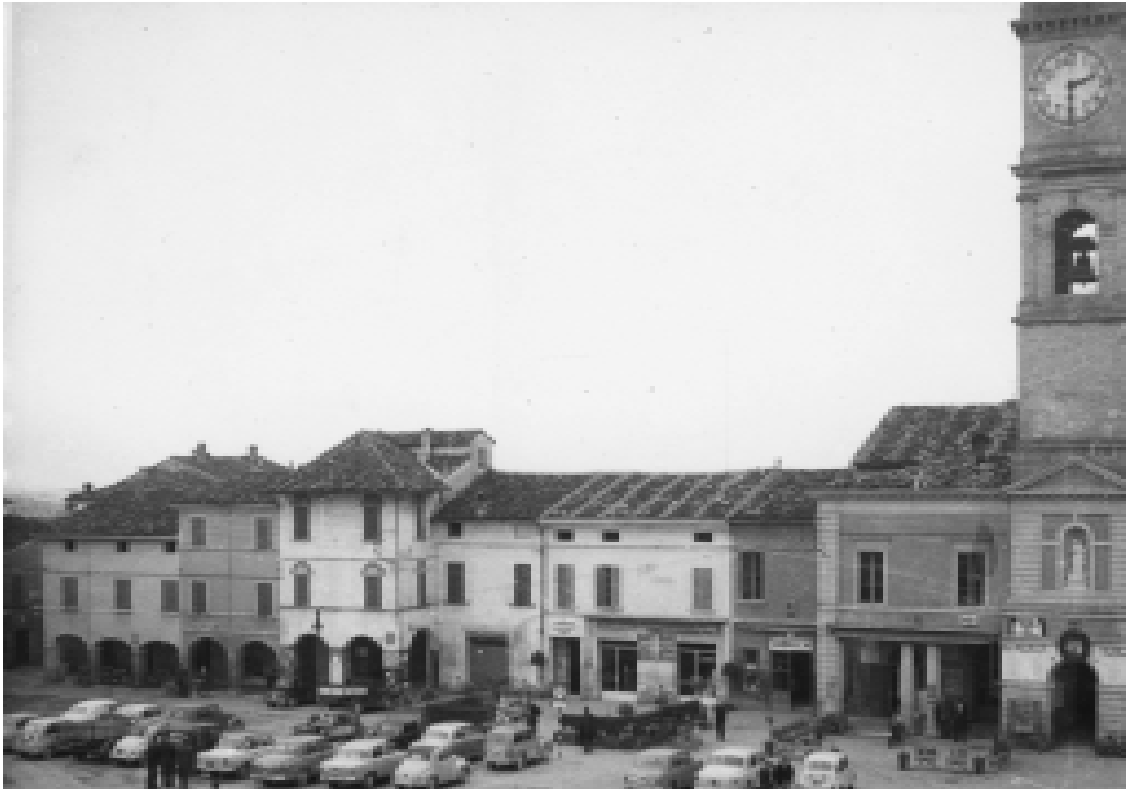
Fig. 1 - Forlimpopoli. Il lato ovest della piazza Garibaldi prima della demolizione della casa di Pellegrino Artusi e di quella attigua posta a Nord (foto di C. Verzocchi, 1961).
